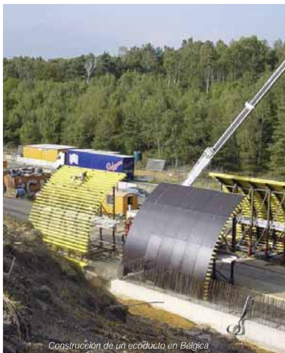
Construcción de un ecoducto en Bélgica
